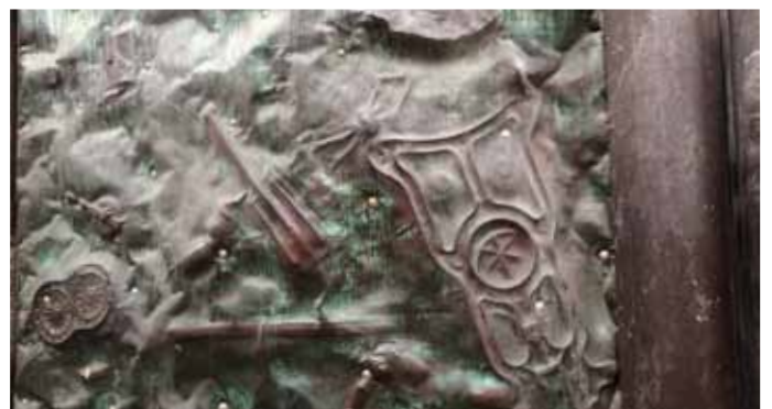
12. En del av en skrotdörr Östgötagatan 14
